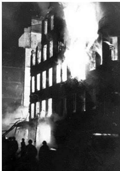
Рисунок 7. Пожар жилого дома в блокадном Ленинграде, 1942 год.
