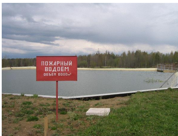
Рисунок 77. Источник (хранилище) воды, используемой при тушении пожаров.
